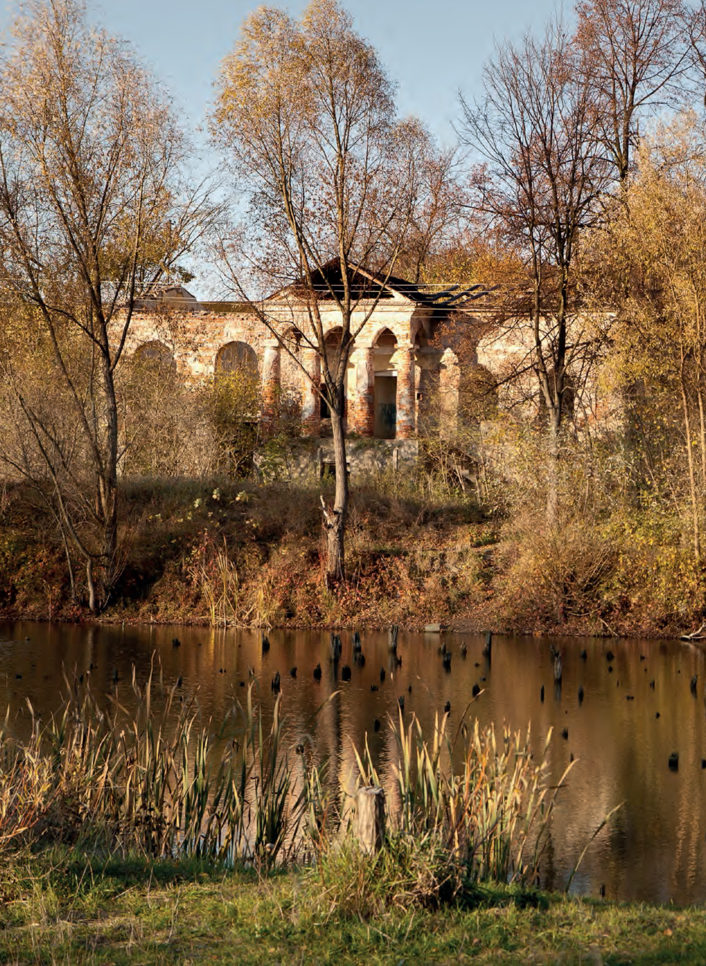
Pozostałości po XIX-wiecznym dworku w Bartodziejach.
