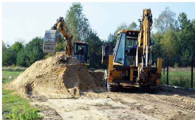
Trwa rozbudowa kanalizacji w gminie Jedlnia-Letnisko. W drugim etapie inwestycji do sieci mogli przyłączyć się mieszkańcy miejscowości: Antoniówka, Dawidów, Groszowice, Siczki, Wrzósów, Jedlnia-Letnisko, a także Kieszek w gminie Pionki. W tym roku nowa sieć zostanie rozprowadzona także we Wrzósowie, Myśliszewicach i Aleksandrowie. Budowa kanalizacji sanitarnej w tych miejscowościach to zadanie 3-letnie, a koszt inwestycji to około 19 mln zł.
