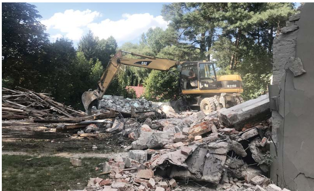
Wykonawca rozpoczął budowę nowego pawilonu od wyburzenia jednego ze starych budynków.
