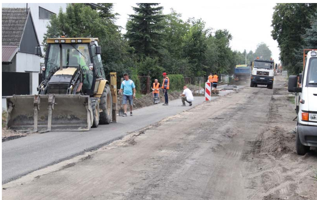
W miejscowości Zalesice-Kolonia trwa przebudowa drogi powiatowej przy której powstanie 2-metrowy chodnik.
