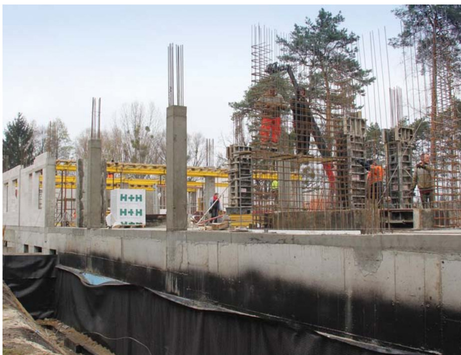
Niespełna dwa miesiące po rozpoczęciu inwestycji, widać już efekty prac budowlanych.
