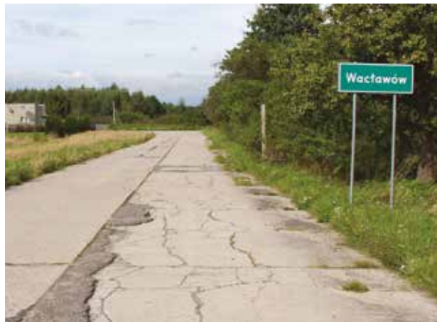
Przebudowany zostanie odcinek drogi Jaszowice – Wactawów – Sławno. To kolejna była droga wojewódzka, przekazana powiatowi w złym stanie technicznym.
