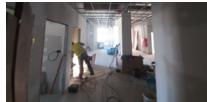
Od kilku miesięcy w nowym pionkowskim szpitalu trwają prace wykończeniowe. Całość ma być gotowa w połowie sierpnia.
