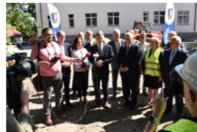
Spotkanie z dziennikarzami na placu budowy nowego szpitala w Pionkach.
